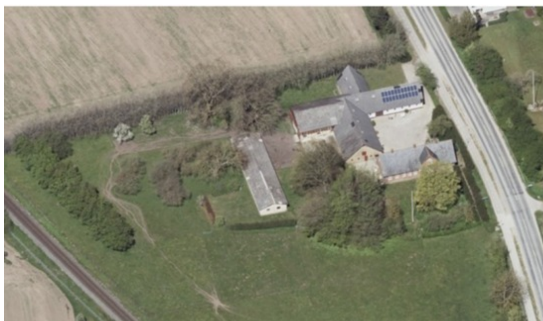
Herunder ses ejendommen fra Svendborgvej. Foto er fra forvaltningens besigtigelse i maj 2025.
