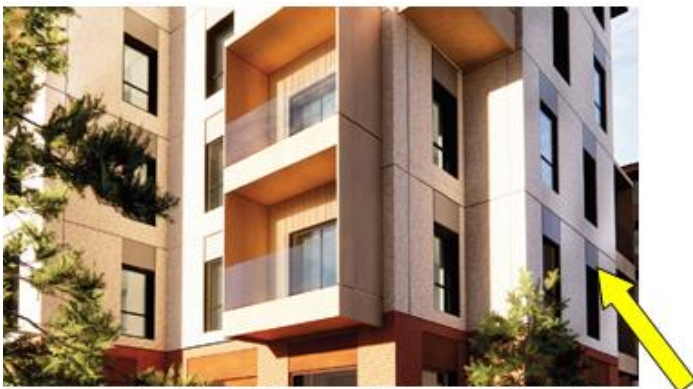
Illustration af betonfelter over vinduer vist med gul pil
