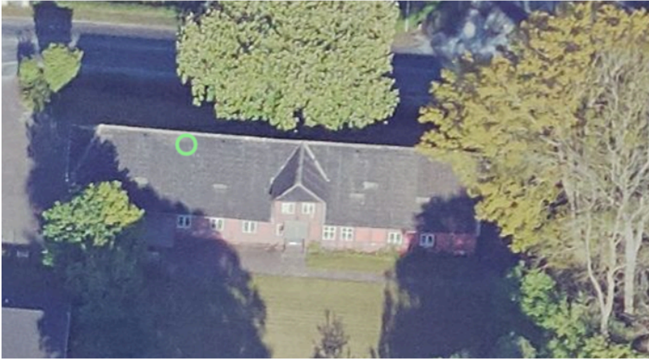
Skråfoto af ejendommens bygning 15/5 2019
