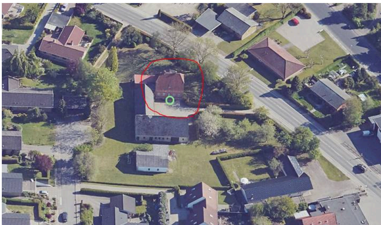
Figur 1. Luftfoto, hvor det bevaringsværdige stuehus er markeret med rød cirkel.
