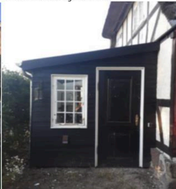
Foto af udhusets gavl mod haven
