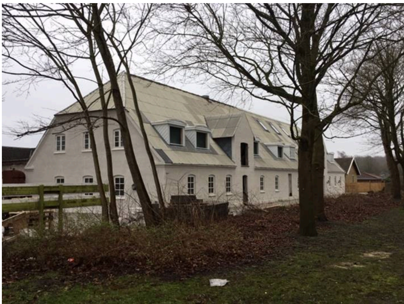
Foto af gl. ladebygning under ombygning, 15/1 2019
