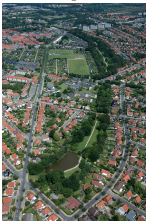
Figur 1 Oversigt over Munkedammen
