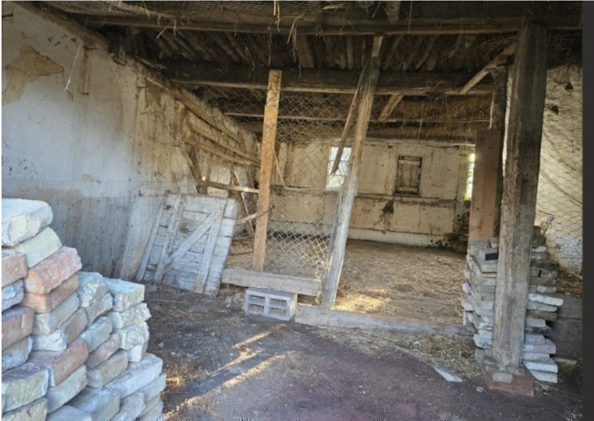
Billede 3: Bygning 2 indefra (SAVE 4)
