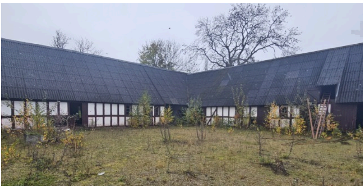
Billede 2: Bygning 2 (SAVE 4)
