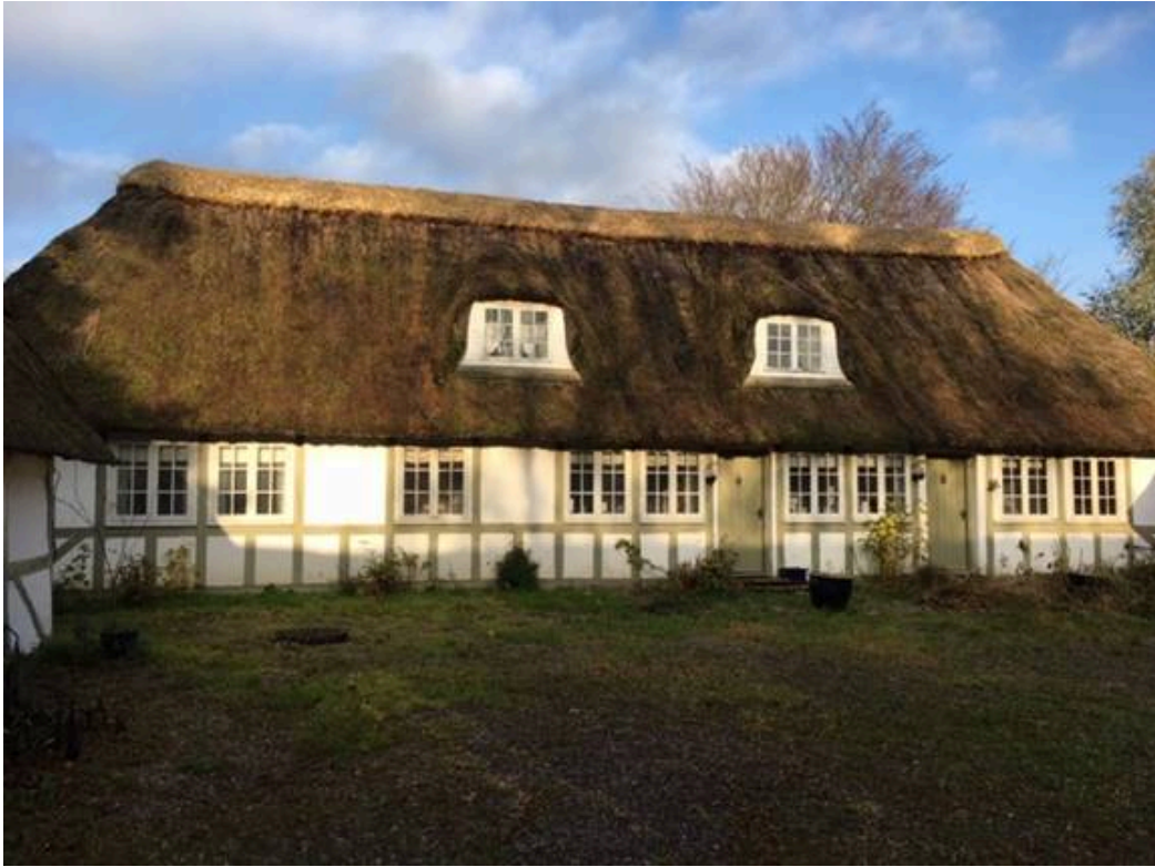
Stuehus (nordlænge) set fra gårdrum, foto 14. november 2019.
